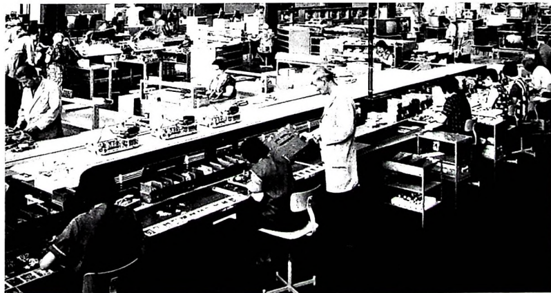
Bild 1. Teilausschnitt aus der Schwarz-Weiß-Fernsehempfänger-Fertigung im Werk Zirndorf von Metz
